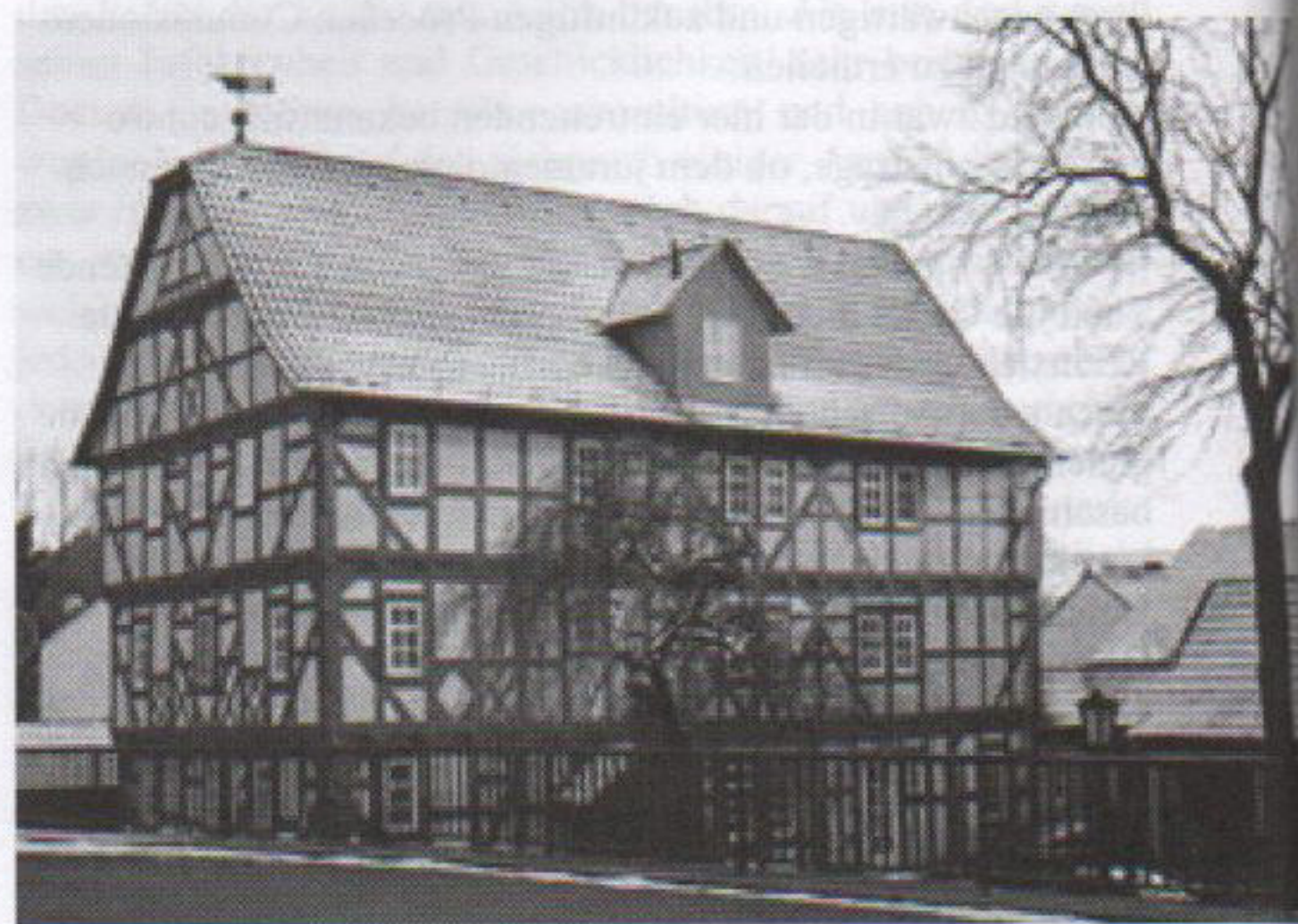
Amtshaus in Kirtorf, sog. Doktorhaus, Aufnahme: Verf. 2006.
